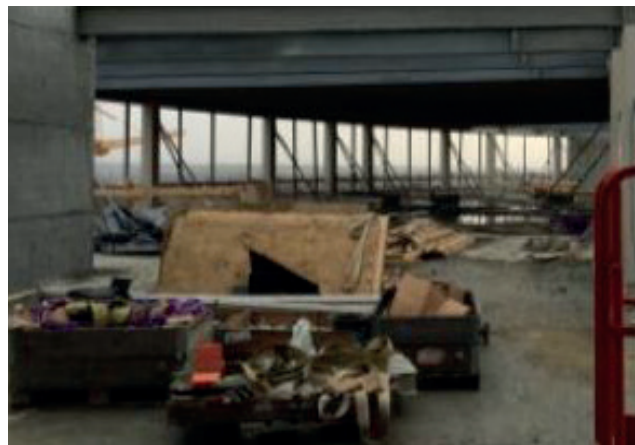
Billede af byggeplads fra det antropologiske feltarbejde.
